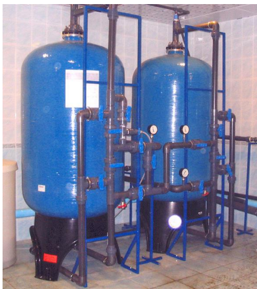
Система умягчения 15 м³/час
