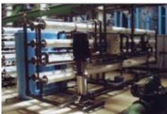
Мембранная система производительностью 50 м³/час
